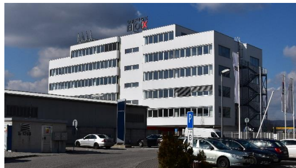
Administrativní budova Office Box, Bratislava, SR
