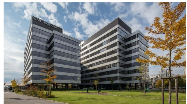
Administrativní budova Metronom Business Center, Praha, ČR
