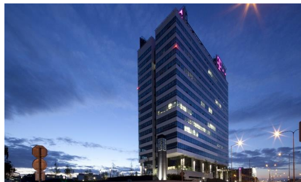
Administrativní budova Forum BC I, Bratislava, SR
